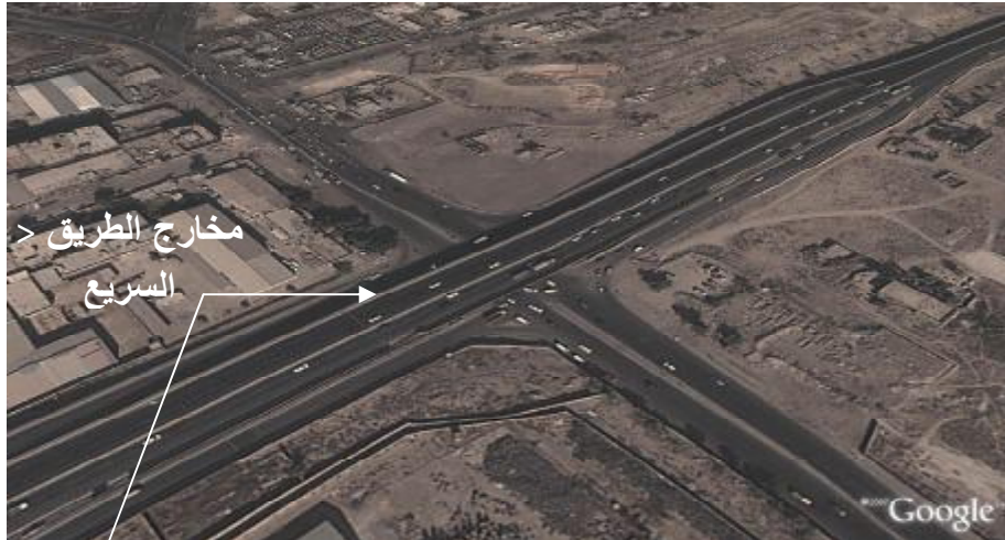
شكل (1) تقاطع الزعفرانية والمنطقة المحيطة.
