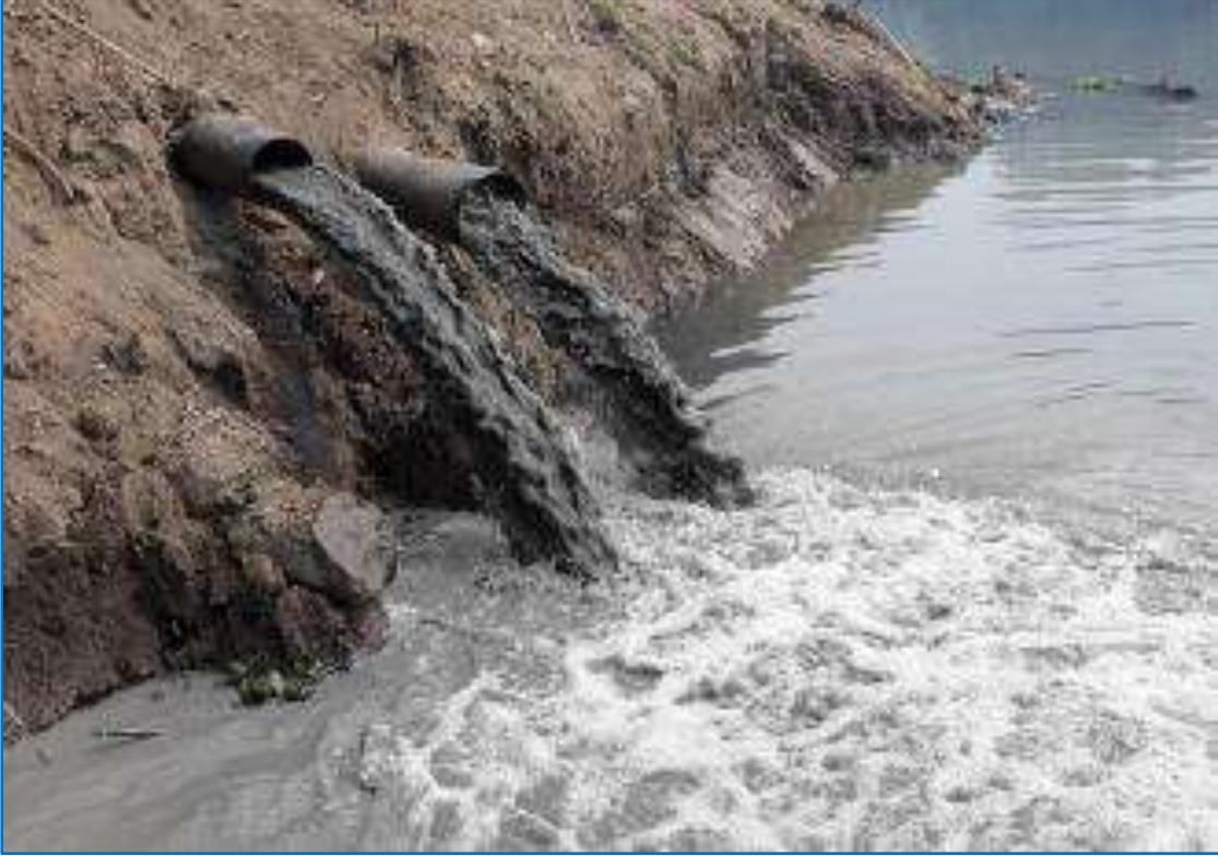
الصورة (3) مجاري الصرف الصحي باتجاه جدول الجربوعية في مدينة القاسم
