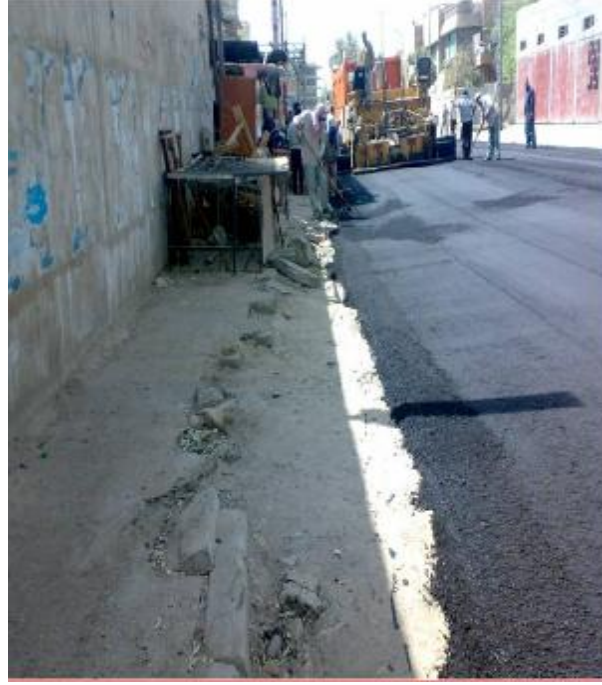
صورة رقم (1) جانب من اعمال الاكساء في احد شوارع بغداد
